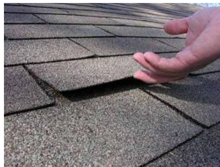
Loose Shingle Tab
